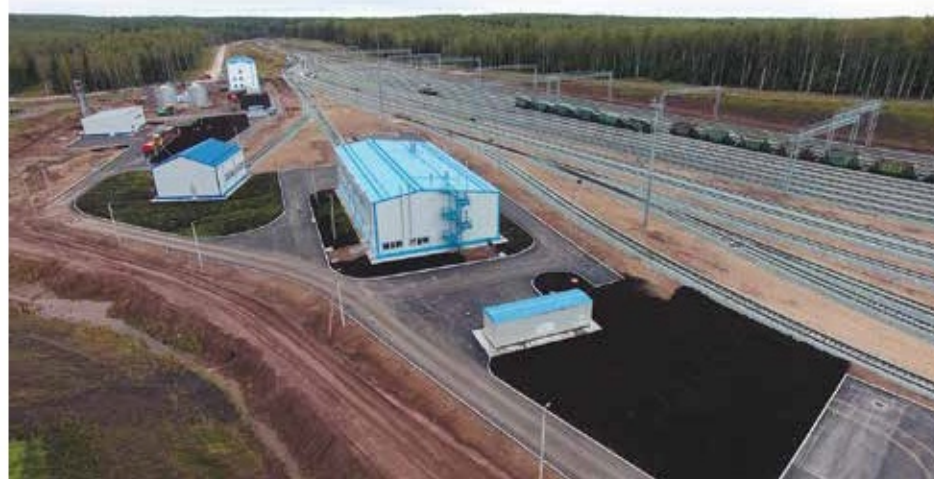
Станция Палашеры на территории Усольского калийного комбината
