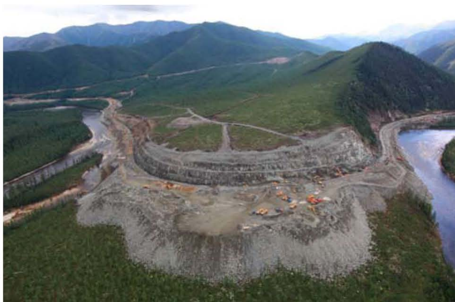
Строительство железной дороги Улак — Эльга
